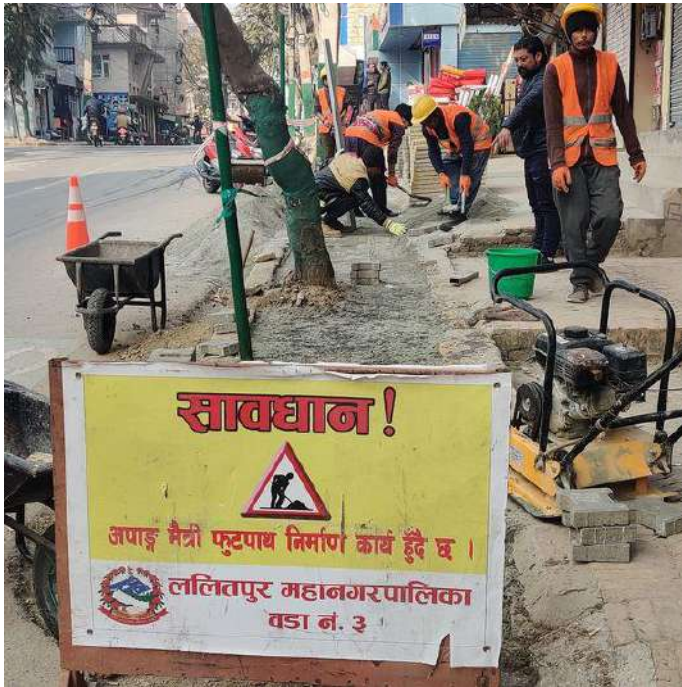
अपाङ्गमैत्री फुटपाथ निर्माण कार्य
